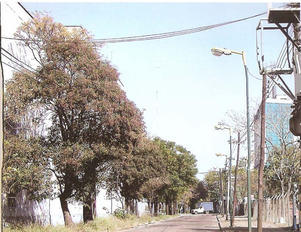
La calle RODRÍGUEZ PEÑA cruza parte del partido de este a oeste y es de gran densidad vehicular, especialmente de vehículos de carga. Se unificó la simetría con columnas de 6,5 m de altura libre con un pescante de 0.50m de largo y ángulo de 15° respecto a la horizontal a 25 m de distancia entre sí.
